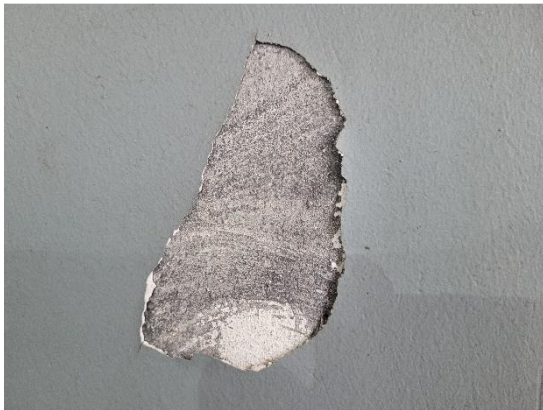
Figura 05. Desprendimiento de pintura hasta superficie de revoque
