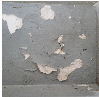
Figura 06. Descascaramientos.
