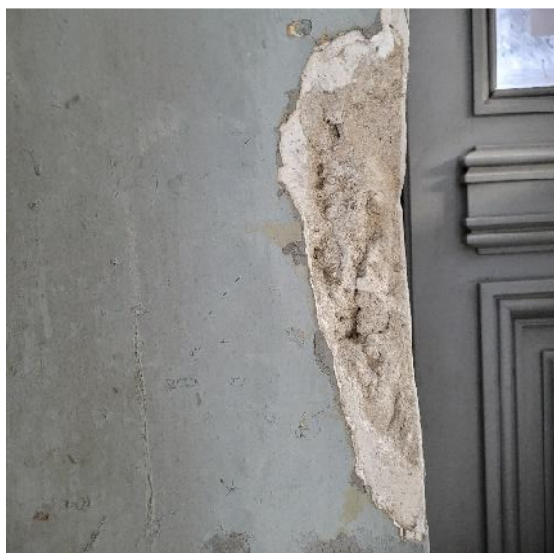
Figura 08. Pérdida de material en base de pilastra
