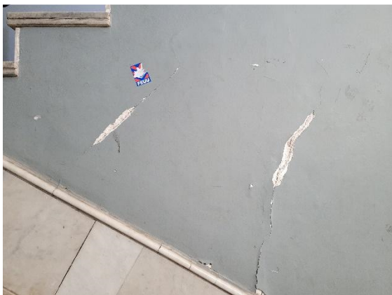
Figuras 12 y 13. Fisura sobre lateral derecho y restos de cinta adhesiva adherida al paramento.
