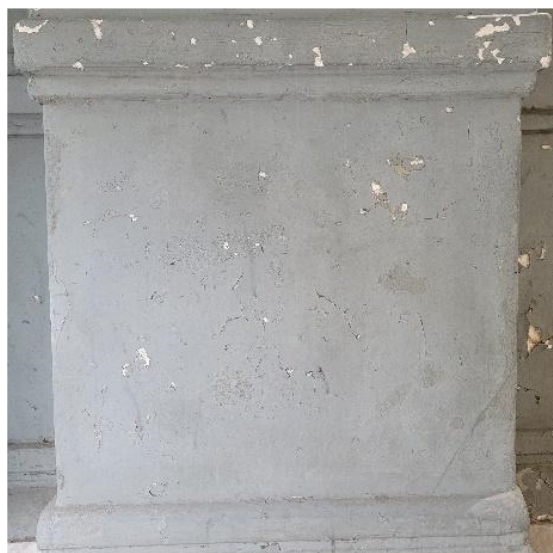
Figura 09. Craquelado de capas de pintura en base pilastra.
