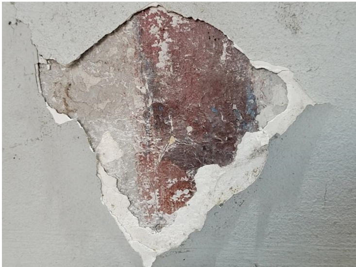
Figura 07. Caso en que será necesaria la restitución de la textura mediante enduido interior
