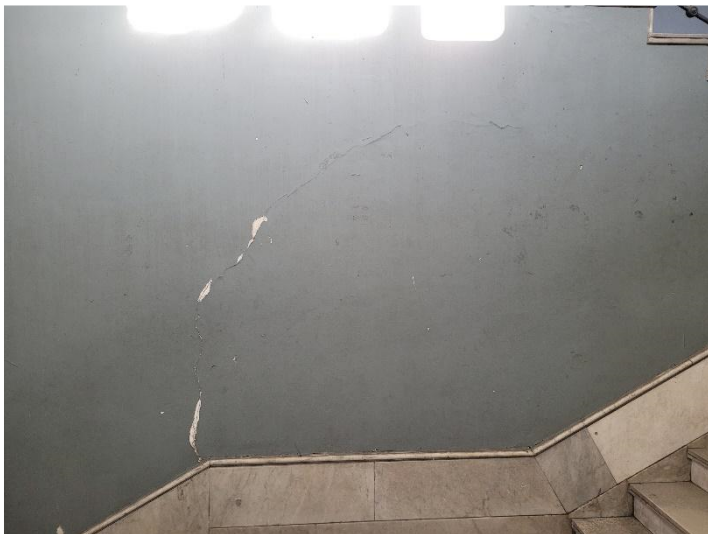
Figuras 14 y 15. Grieta marcada sobre lateral izquierdo y detalle de arranque de grieta contra zócalo de mármol.
