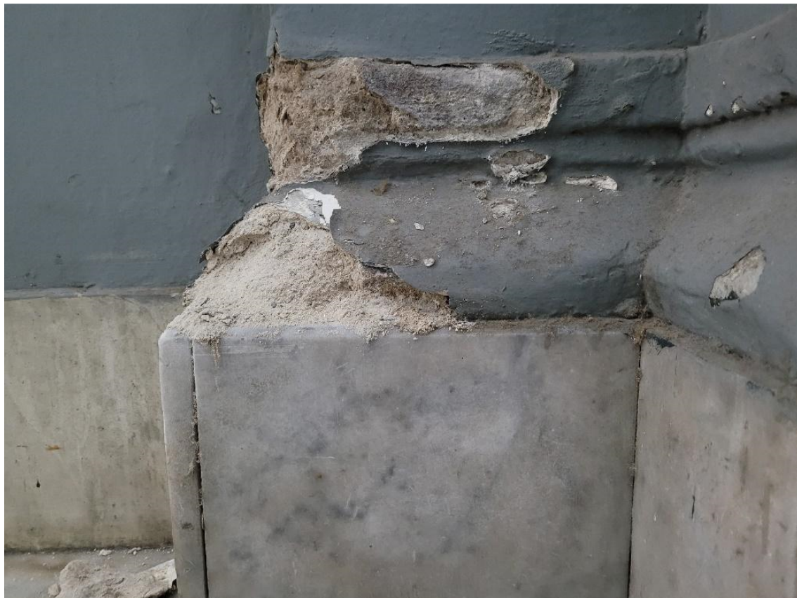
Figura 10. Reconstitución de moldura. La mezcla se presenta arenada, producto del paso del tiempo
