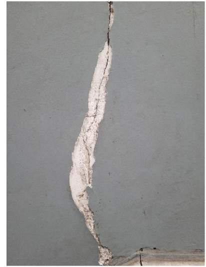
Figuras 14 y 15. Grieta marcada sobre lateral izquierdo y detalle de arranque de grieta contra zócalo de mármol.
