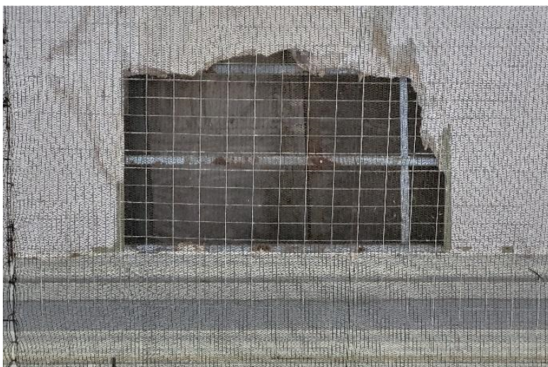
Figura 26. Detalle de cielorraso en galería derecha de planta alta. Véase el desprendimiento del material de terminación (yeso) por sobre el nivel del mallado de protección.
