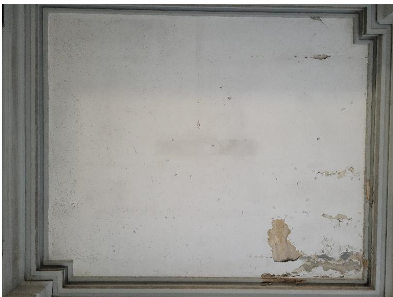
Figura 24. Fotografía de cielorraso con desprendimiento de revoques y pinturas. Las áreas de esquina no presentan un deterioro tal, para que sea necesaria su protección, de cualquier manera, forman parte de la intervención.
